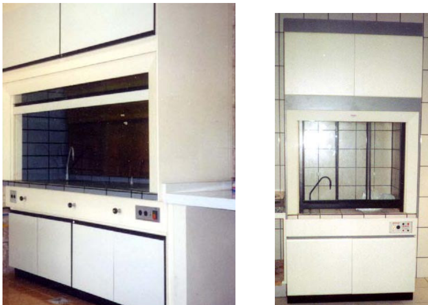
Figura 3 - Capelas utilizadas para tratamento de resíduos com metais.
